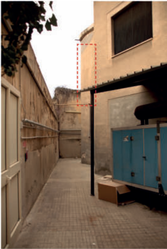
A sinistra, foto dell'interno allo stato attuale con in evidenza i cambi di sezione dei pilastri in prossimità della quota di imposta del solaio storico demolito recentemente.
